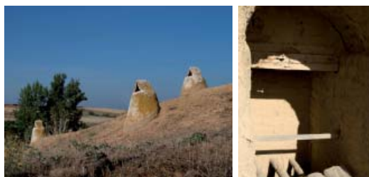
Figuras 4 y 5. Izq: Zarceras de una bodega de Pajares de los Oteros. Dcha: Descargadero.
